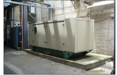
FOTO 2 PORTICO - Base in cls da sistemare per posizionamento nuovo G.E.
