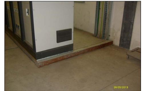
FOTO 1 CABINA ELETTRICA - Abbigliamento base per nuovo quadro elettrico
